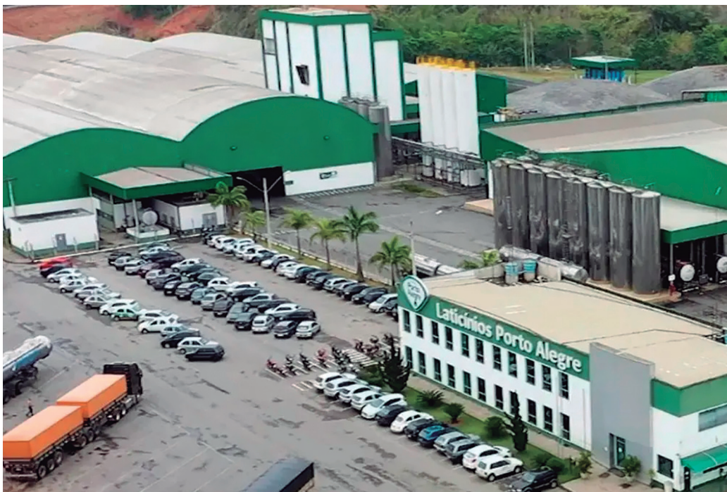
Na Laticínios Porto Alegre, trabalho do técnico é fundamental para garantir o correto funcionamento de bombas, trocadores de calor, sensores e controles
