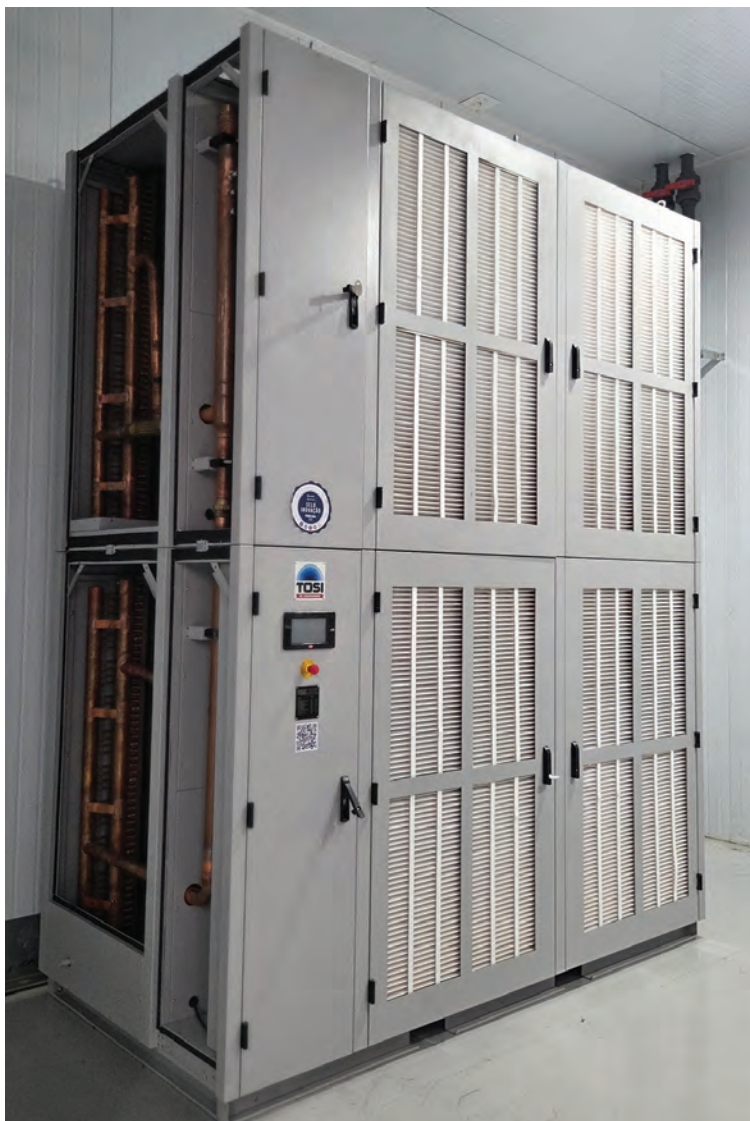
Equipamento desenvolvido para atender a demanda de data centers hyperscale , com fluxo de ar horizontal que permite operar com temperatura de água gelada mais altas nos chillers
