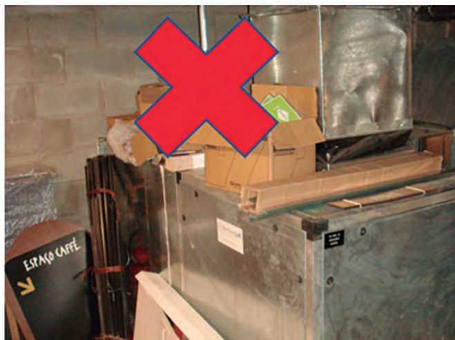
Casa de Máquinas não adequadas utilizadas como depósito!
