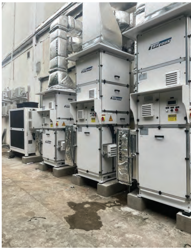
UTAs (Unidades de Tratamento de Ar) possuem diferentes configurações para atender projetos variados e arquiteturas complexas para ambientes hospitalares
