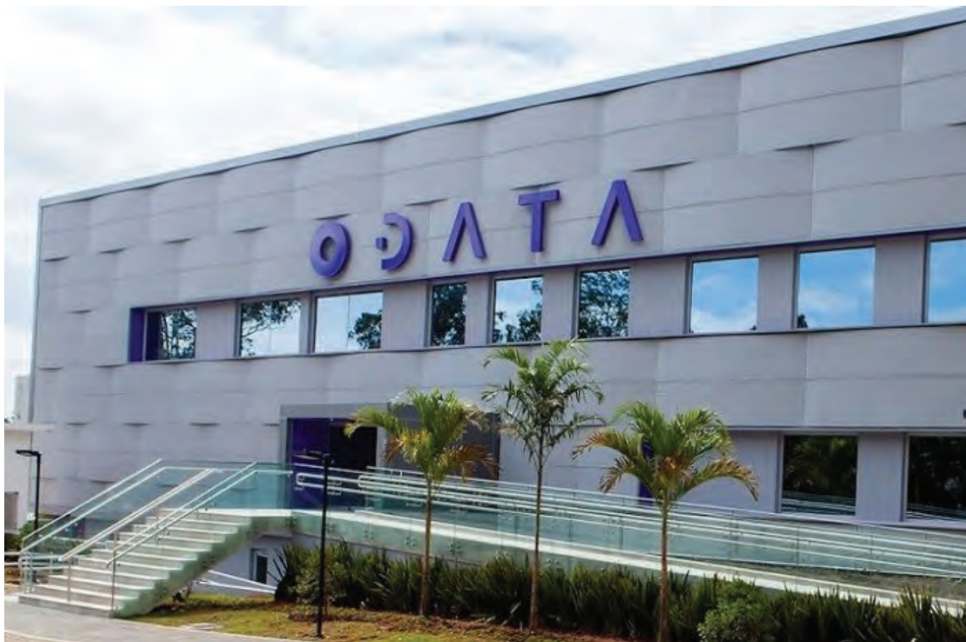
SP04 adotou sistema de resfriamento a ar de alta eficiência com 100% de energia proveniente de fontes renováveis
