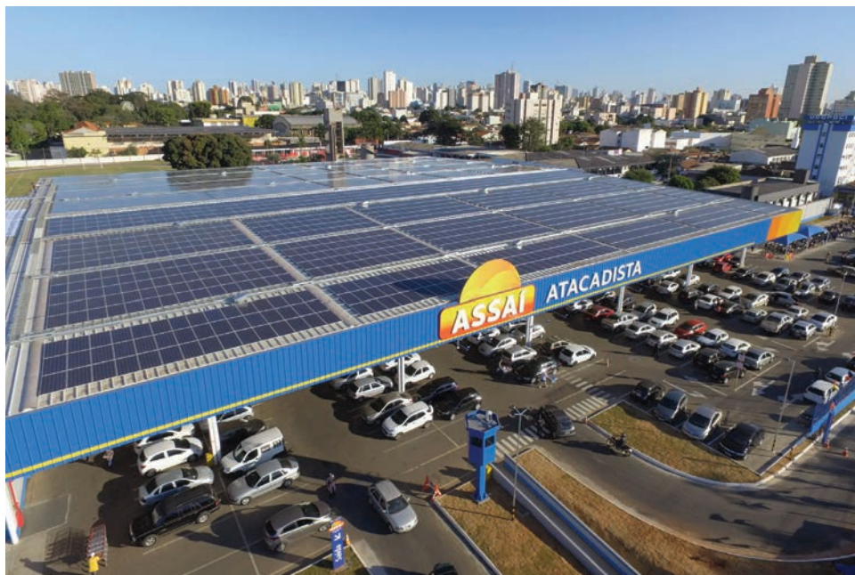
Rede Assaí já utiliza energia solar em algumas de suas unidades, instalando painéis fotovoltaicos
