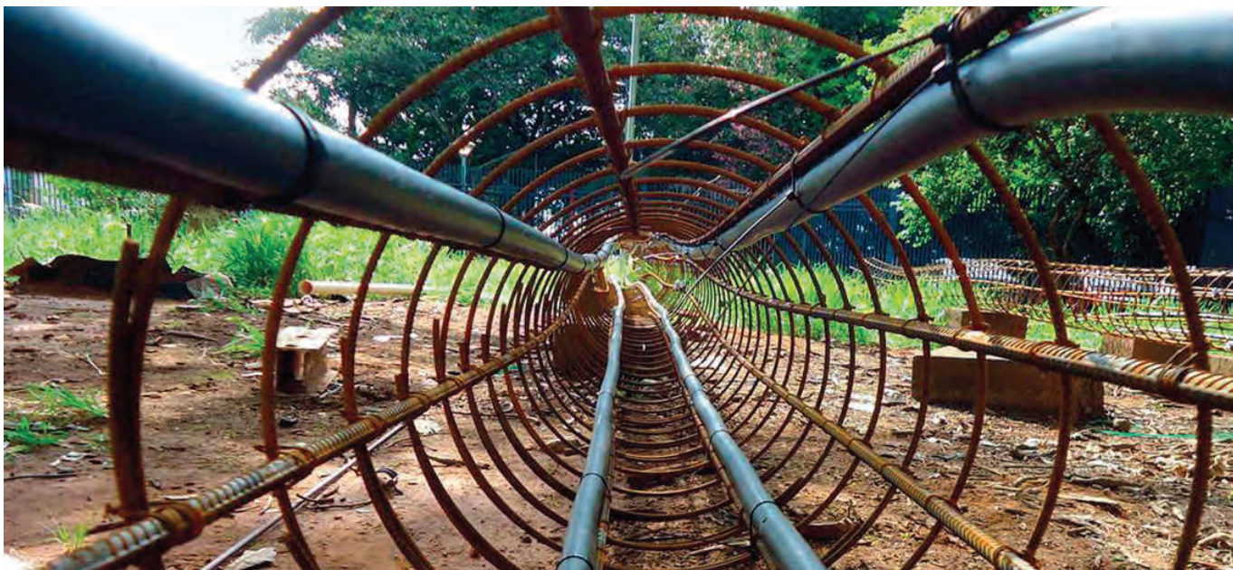
Em obras, o CICS Living Lab da POLI-USP estudará sobre o aproveitamento da energia térmica presente no subsolo para climatizar ambientes
