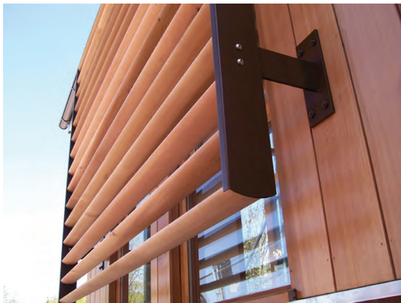
Proteções solares, como brises, ajudam a diminuir a carga térmica ambiente
