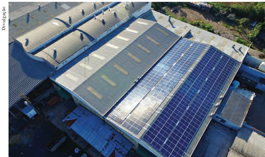
Tecnologias de armazenamento de energia solar podem ser aplicadas tanto na eficiência do sistema de climatização, como na gestão de consumo e qualidade de energia
