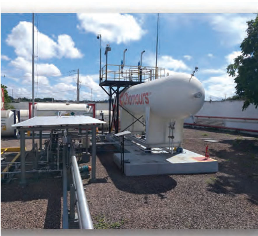
Fábrica da Chemours: Colaboração com órgãos governamentais locais e consultorias especializadas para garantir o cumprimento de todas as exigências
