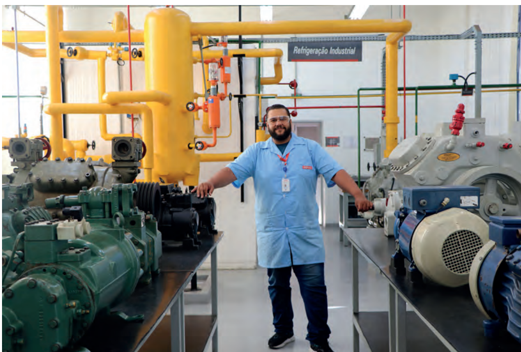
As inovações tecnológicas continuam a moldar o setor de HVAC-R, desempenhando papel fundamental na melhoria dos sistemas
