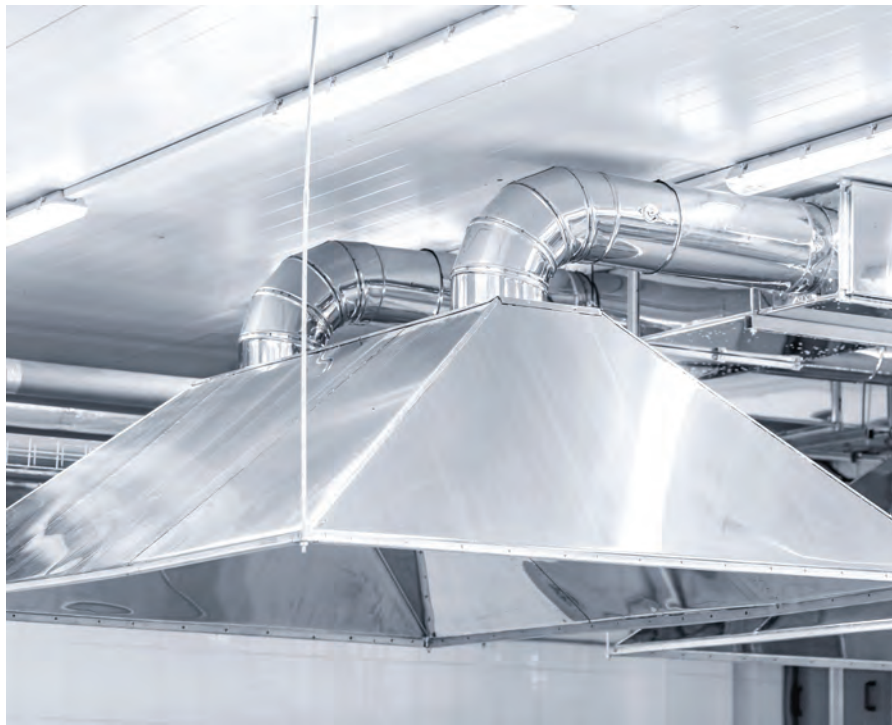
Objetivo da ventilação profissional em cozinhas é assegurar a renovação do ar, evitando a presença de fungos, gases e fumaça, entre outros elementos em suspensão
