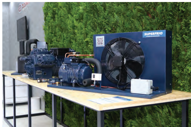
Unidade condensadora com compressor semi-hermético Dorin no estande da Superfrio
