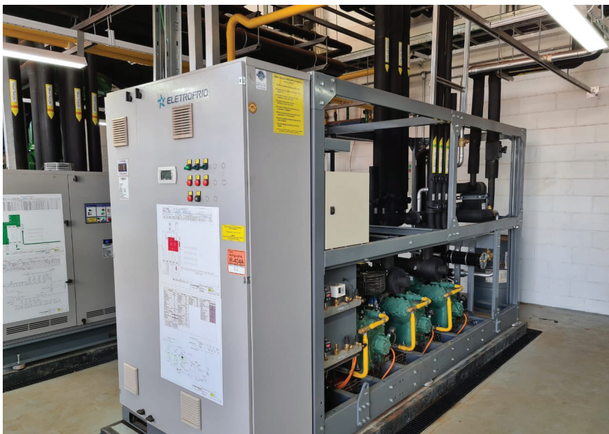
Rack de refrigeração fabricado pela Eletrofrío
