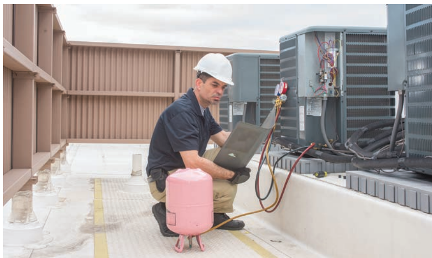
Fabricantes de sistemas de ar condicionado têm apostado, cada vez mais, na qualificação de mão de obra
