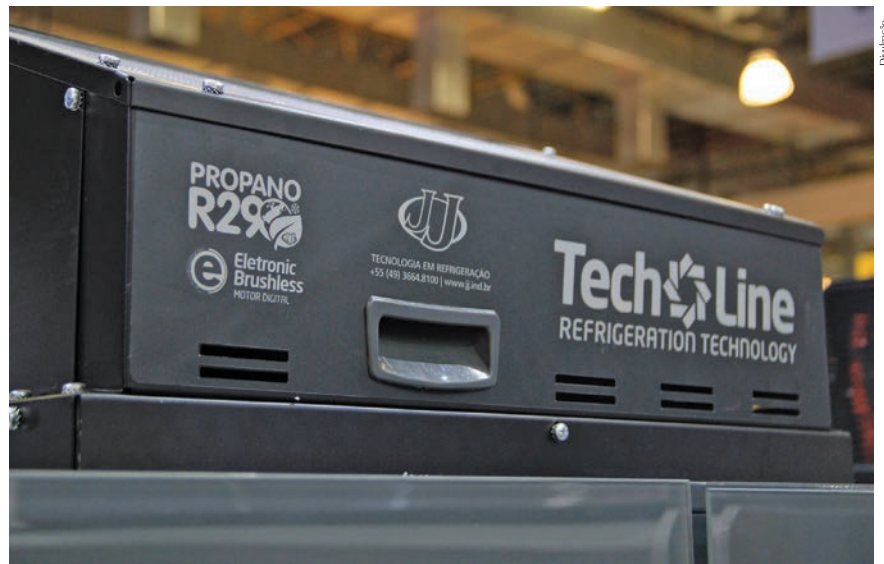
Unidade plug-in com R-290 instalada em expositor frigorífico
